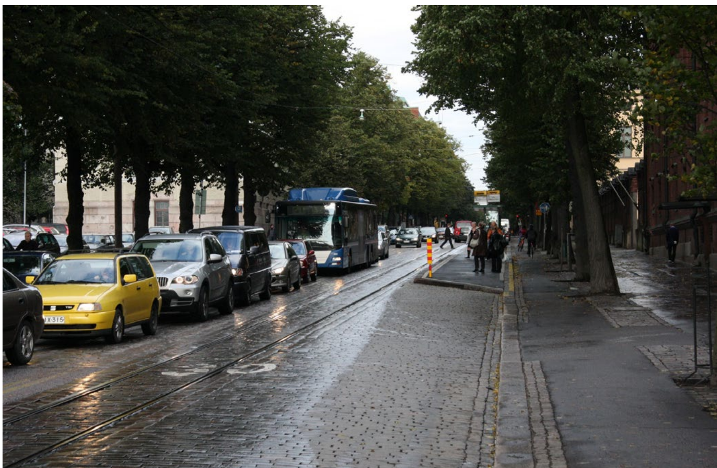
Platforma przystanku tramwajowego dosunięta do pojazdu i zwężająca jezdnię. Helsinki (Finlandia) fot. T.Bużatek
